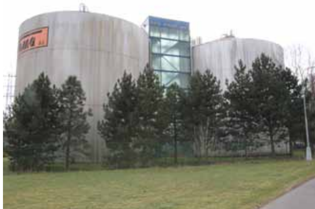
Čistírna odpadních vod v Otrokovicích. Foto: Anna NOVOTNÁ
