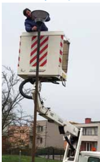
Výměna. Pracovníci technických služeb postupně obměňují sodíkové výbojky za LED osvětlení. Foto: MÚ Otrokovice
