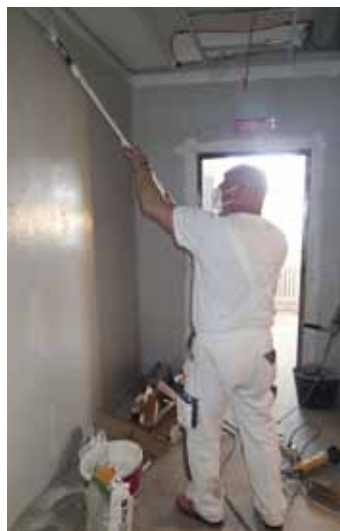
Při práci. Dělníci aktuálně pracují ve 3. a 4. patře. Foto: Šárka Šarmanová
