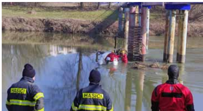
V akci. Náročné bylo vytažování nánosů na ledolamech.
